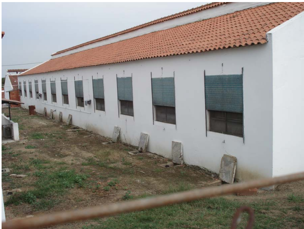
Figura.5 - Aspecto do exterior de um pavilhão de engorda.
